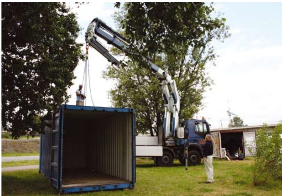
Żuk Piwkowski pilnuje dostawy drugiego kontenera/ Żuk Piwkowski supervises the transport of the second container, ARCH
